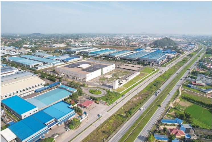
Khu công nghiệp Diêm Thụy tỉnh Thái Nguyên
