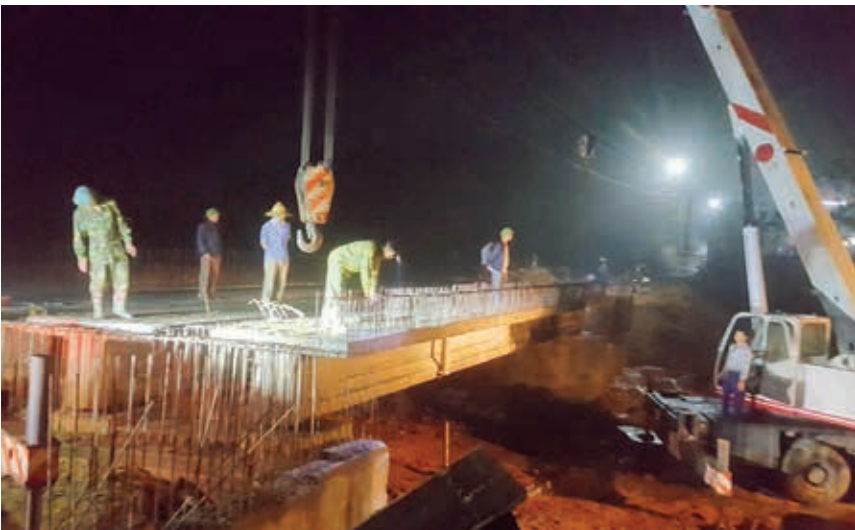
Quang cảnh thi công xây dựng cầu xóm Guộc, năm 2020
