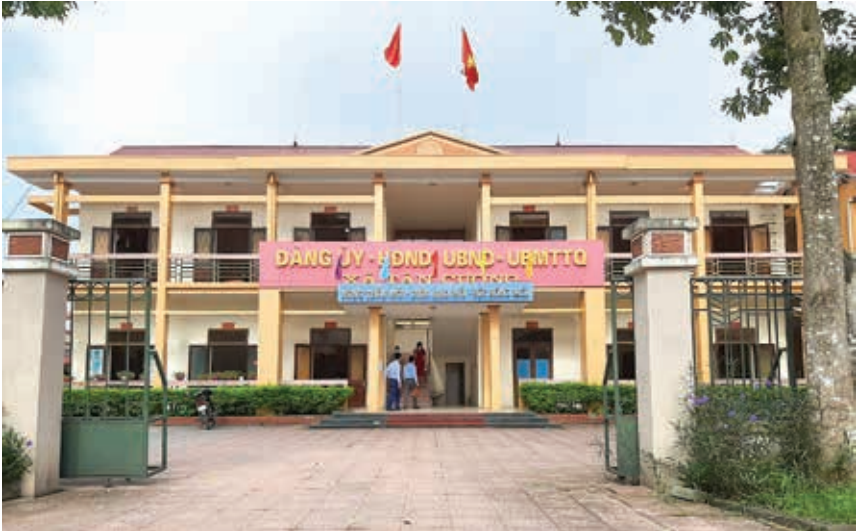
Trụ sở Đảng ủy - Hội đồng nhân dân - Ủy ban nhân dân - Ủy ban Mặt trận Tổ quốc xã Tân Cương xây dựng năm 1994 (Ảnh chụp năm 2020)
