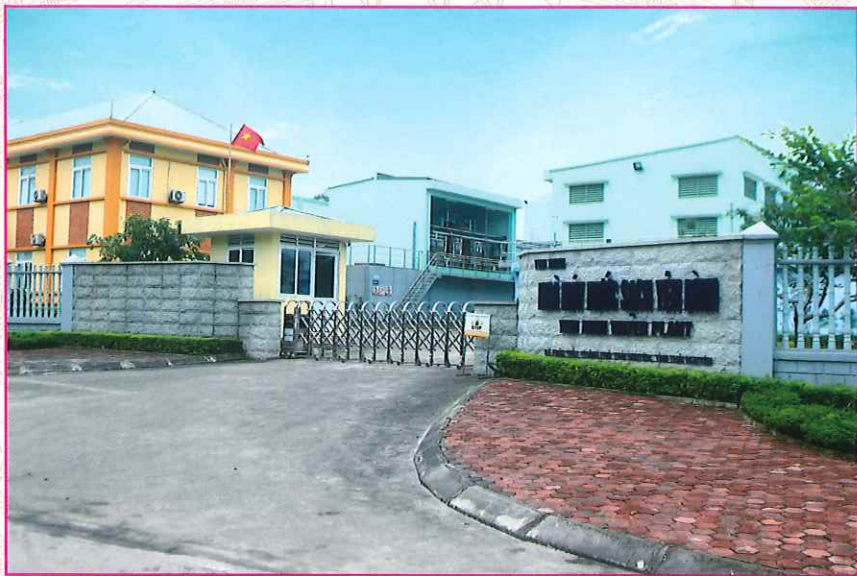
Nhà máy nước sạch Yên Bình
