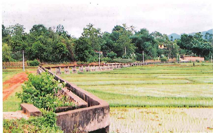
Một đoạn mương được kiên cố hoá tại xóm Thông
