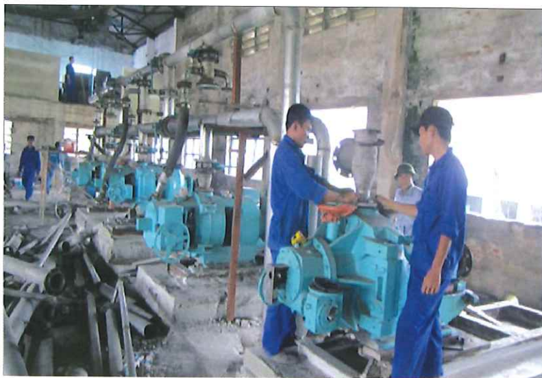
Công nhân Công ty giấy Hoàng Văn Thụ lắp ráp dây chuyền sản xuất
