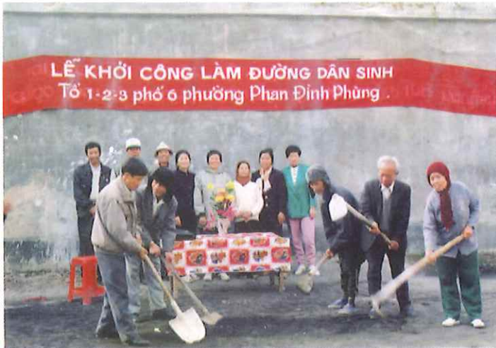
Lễ Khởi công làm đường dân sinh của Phố 6, phường Phan Đình Phùng (năm 1992)
