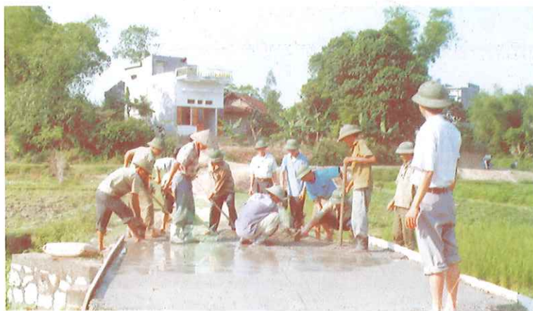
Khởi công xây dựng đường bê tông của tổ 26 Tân Quang phường Đồng Quang (Tháng 6-2002)
