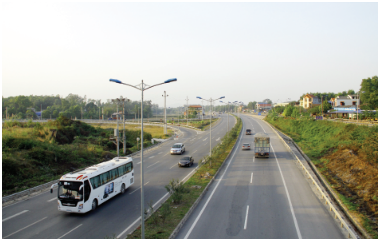
Nút giao Tân Lập trên đường cao tốc quốc lộ 3 mới Hà Nội - Thái Nguyên
