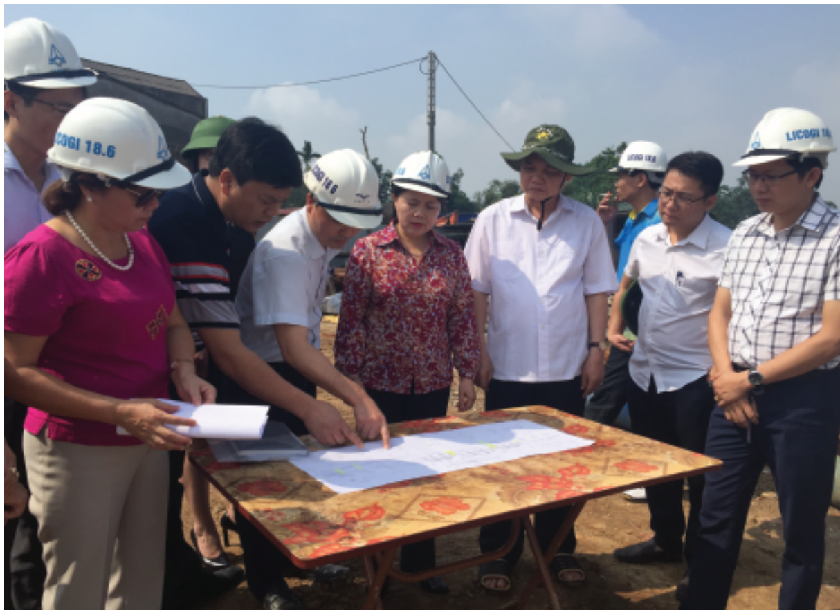
Các đồng chí lãnh đạo Thành phố kiểm tra tiến độ triển khai các công trình dự án trên địa bàn (5/2017)
