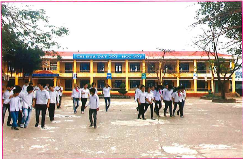
Trường Trung học cơ sở Thành Công (năm 2015)
