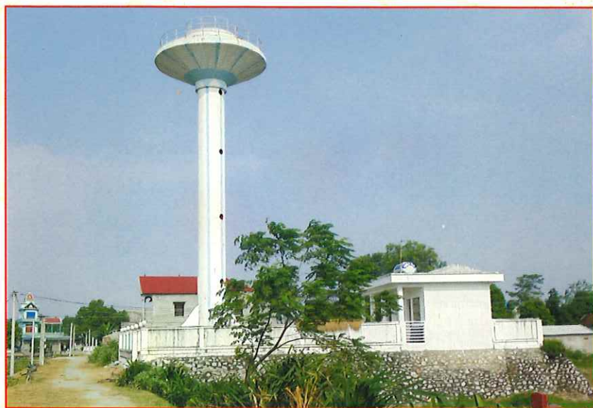
Trạm nước sạch thôn Phú Cốc
