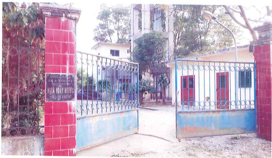
Nhà máy nước Nam Tiến xây dựng và khánh thành năm 2014, đảm bảo cung cấp đủ nước sạch cho hơn 1.000 hộ dân trong xã. (Ảnh chụp năm 2014)
