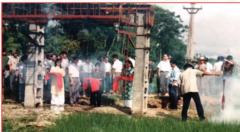
Lễ khánh thành Trạm biến áp Cầu Gô, tháng 8/1993
