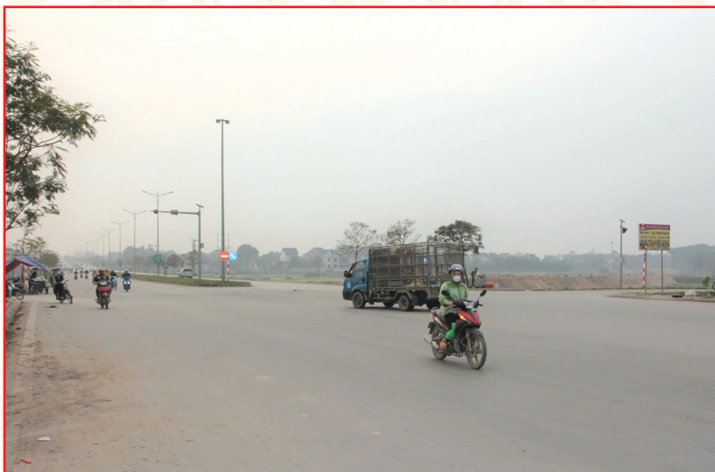
Một góc đường vành đai V qua địa bàn phường Tiên Phong năm 2022
