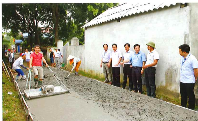
Đầu tư làm đường bê tông tại xóm Cầu Sơn, xã Trung Thành.
