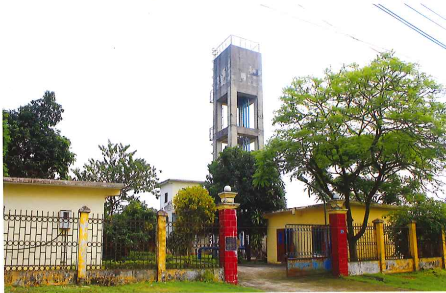
Công trình nước sạch tại xã Nam Tiến.
