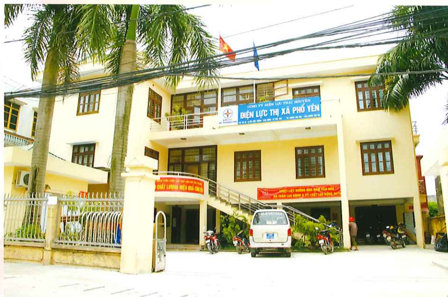
Trụ sở Điện lực Phổ Yên.
