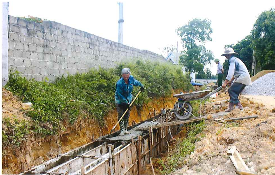
Phong trào làm đường giao thông được người dân các xã nhiệt tình hưởng ứng.
