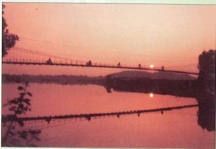
Cầu Hống Thượng Ảnh: ĐÀO THÀNH
