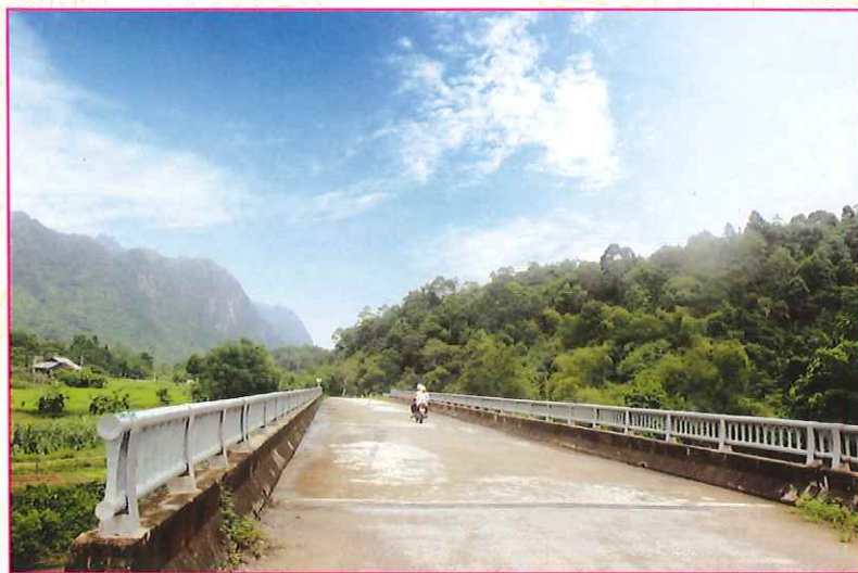
Cầu Na Mấy, xã Vũ Chấn
