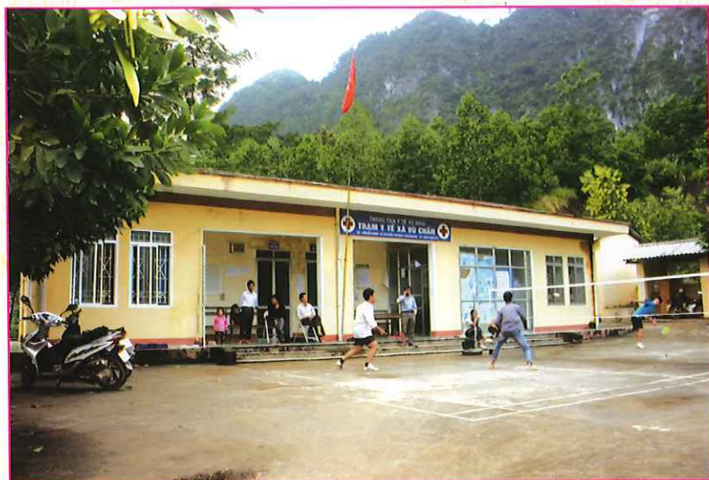
Trạm Y tế xã Vũ Chấn
