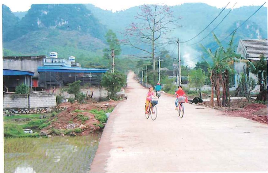
Đường giao thông nông thôn xóm La Đồng xây dựng theo tiêu chí đường giao thông nông thôn mới 2012-2013.
