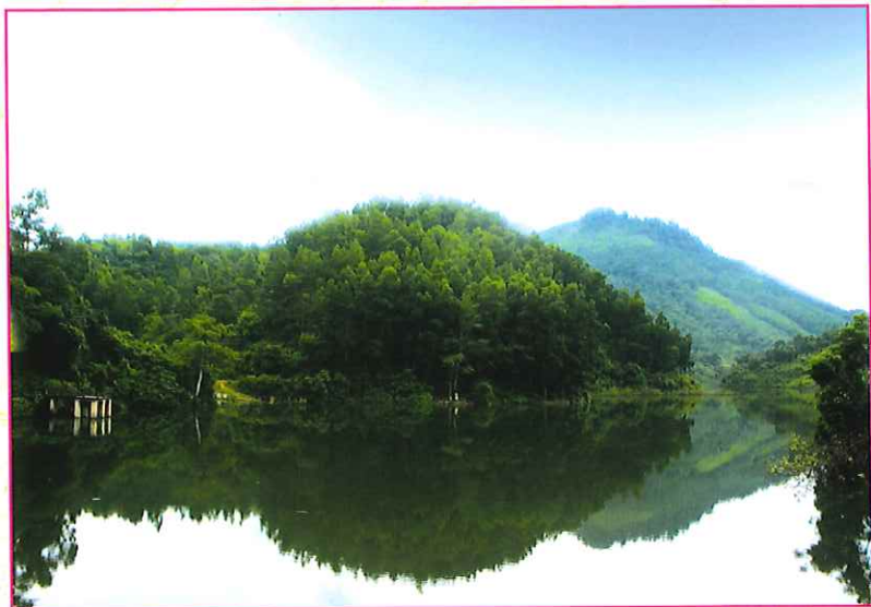
Đập thủy lợi Quán Chẽ, xã Dân Tiến cung cấp nước tưới cho 2 xã Dân Tiến và Bình Long
