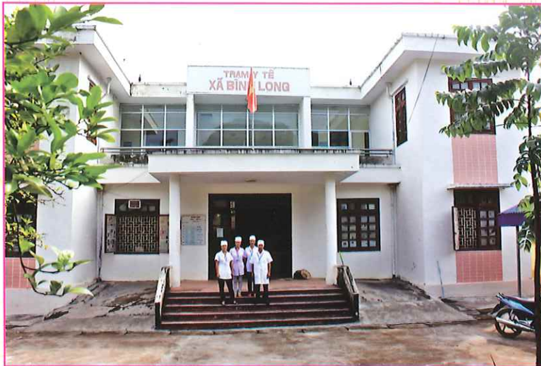
Trạm Y tế xã Bình Long
