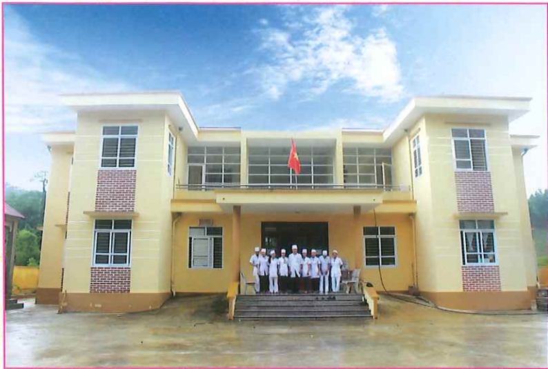
Trạm Y tế xã Cúc Đường
