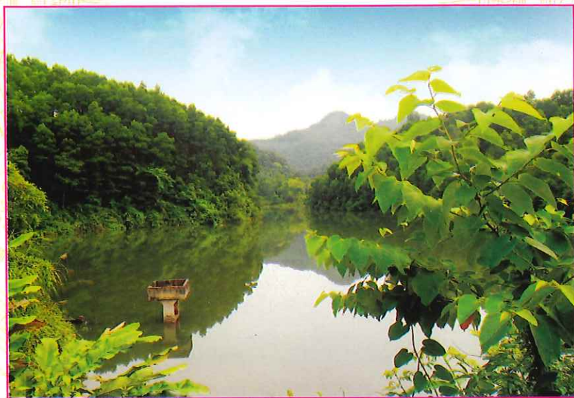
Hồ Na Hiền - một trong những công trình thủy lợi lớn trên địa bàn xã Yên Trạch
