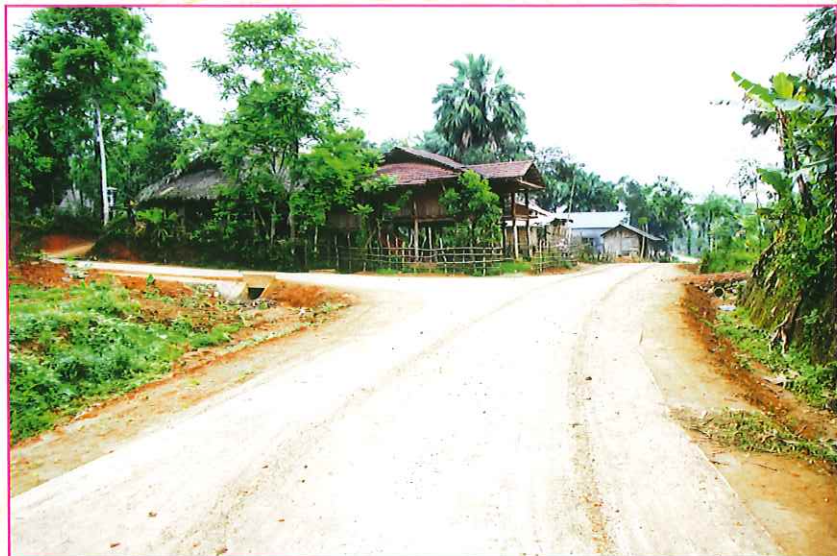
Hệ thống đường giao thông được bê tông hóa
