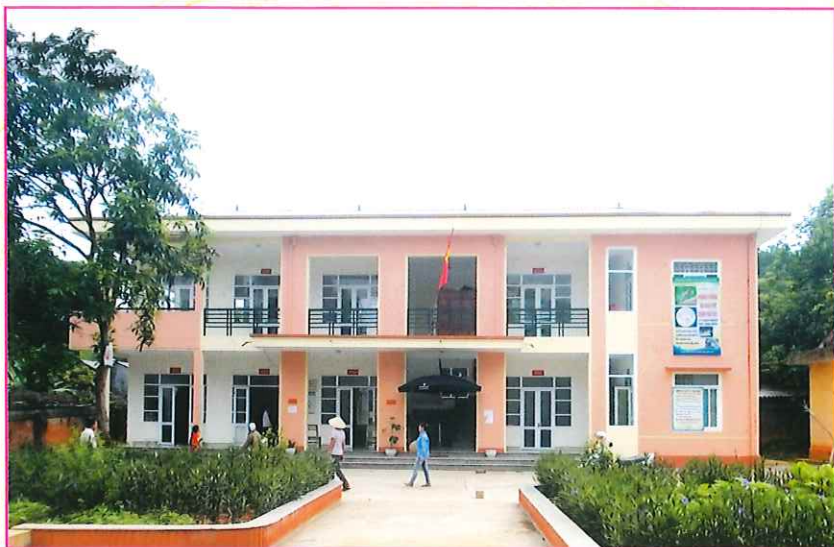
Trạm y tế xã Yên Đỗ (xã đạt chuẩn quốc gia về y tế năm 2005)
