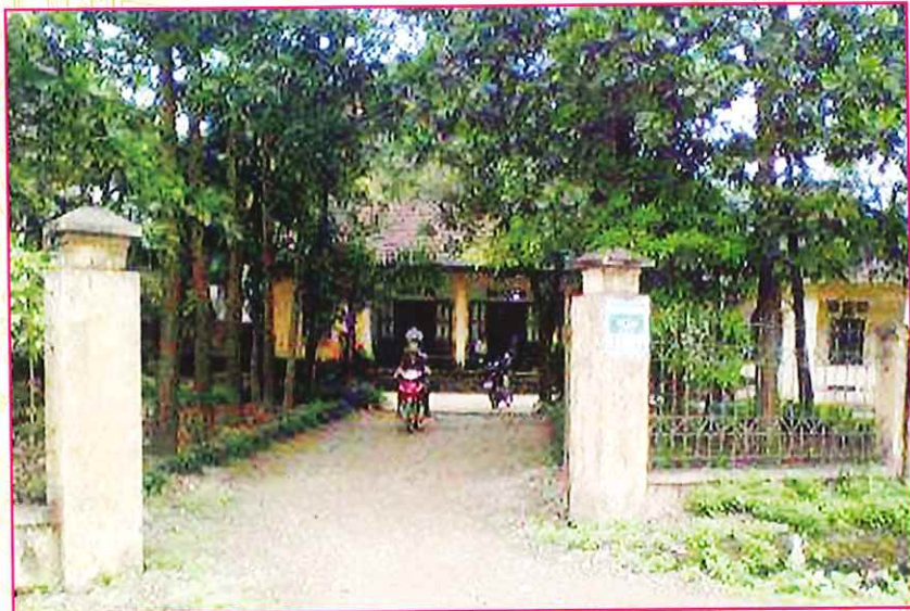
Trạm y tế xã Phú Lý (xã đạt chuẩn quốc gia về y tế năm 2006)
