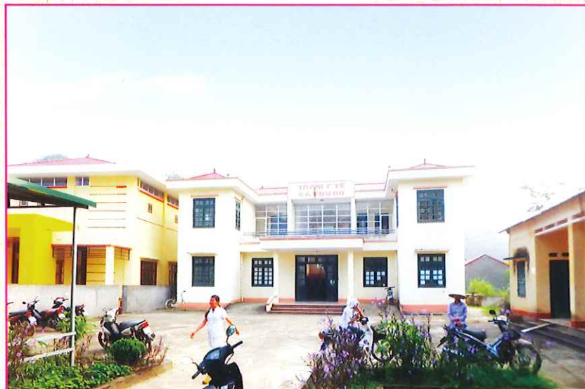
Trạm y tế xã Phú Đô
