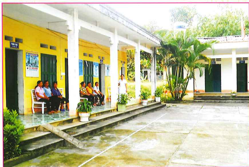
Trạm y tế xã Ôn Lương
