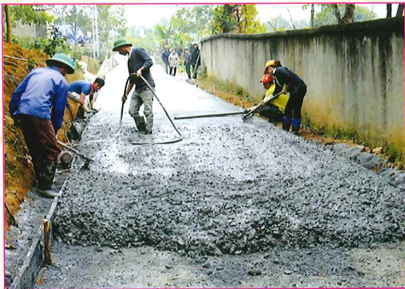
Nhân dân xã Động Đạt xây dựng đường giao thông nông thôn
