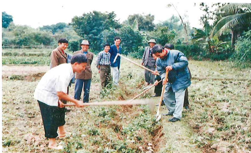
CÁN BỘ VÀ NHÂN DÂN THỊ TRẤN GIANG TIỀN XÂY DỰNG HỆ THỐNG KÊNH MUƠNG THỦY LỢI (NĂM 1999)
