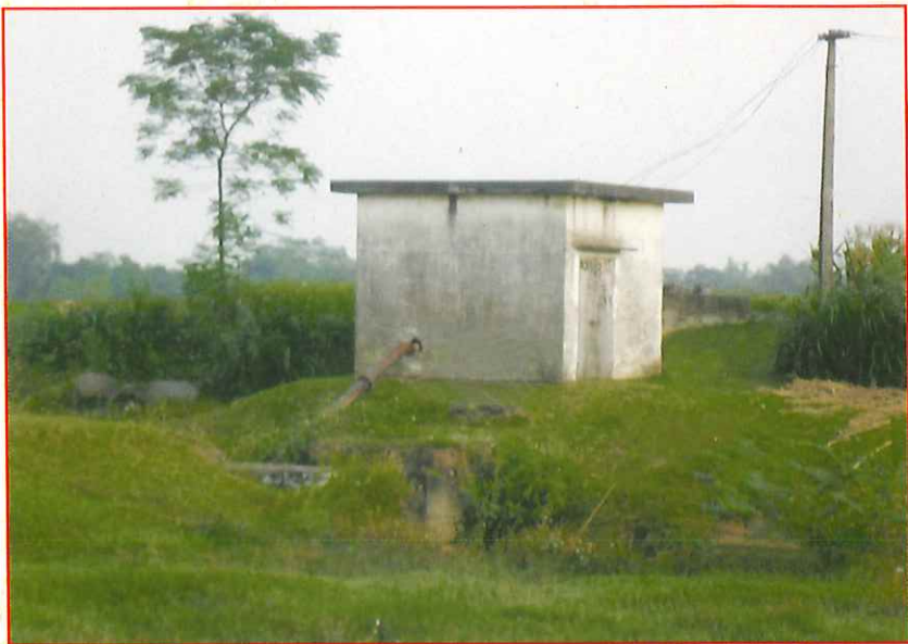
Trạm bơm xã
