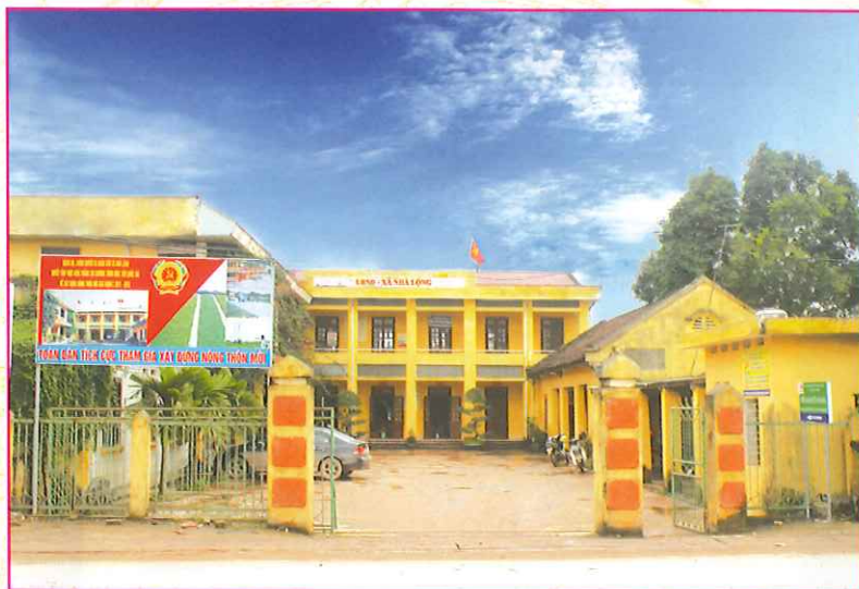
Công sở Đảng ủy - HĐND - UBND xã Nhả Lộng
