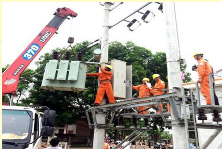
Công ty Điện lực Thái Nguyên lắp đặt Trạm Biến áp 22kV và chuyển thành công lưới điện từ 10kV lên 22kV tại huyện Phú Bình (năm 2017)
