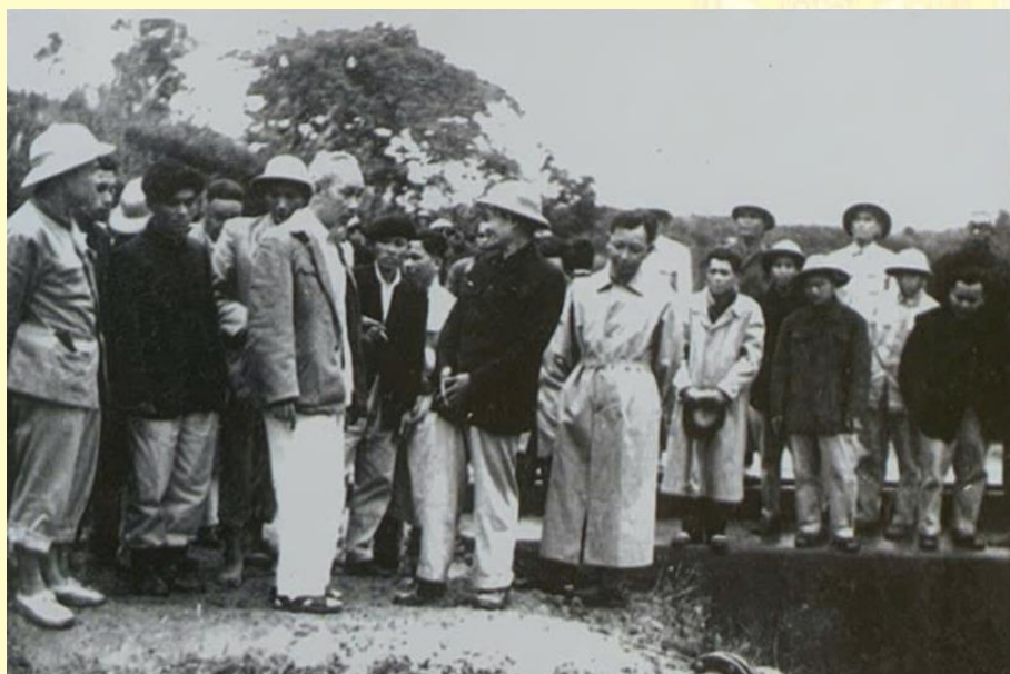
Chủ tịch Hồ Chí Minh đến thăm và kiểm tra công tác chống hạn tại kè Lũ Yên, xã Yên Thịnh (nay là xã Đào Xá) năm 1958.
