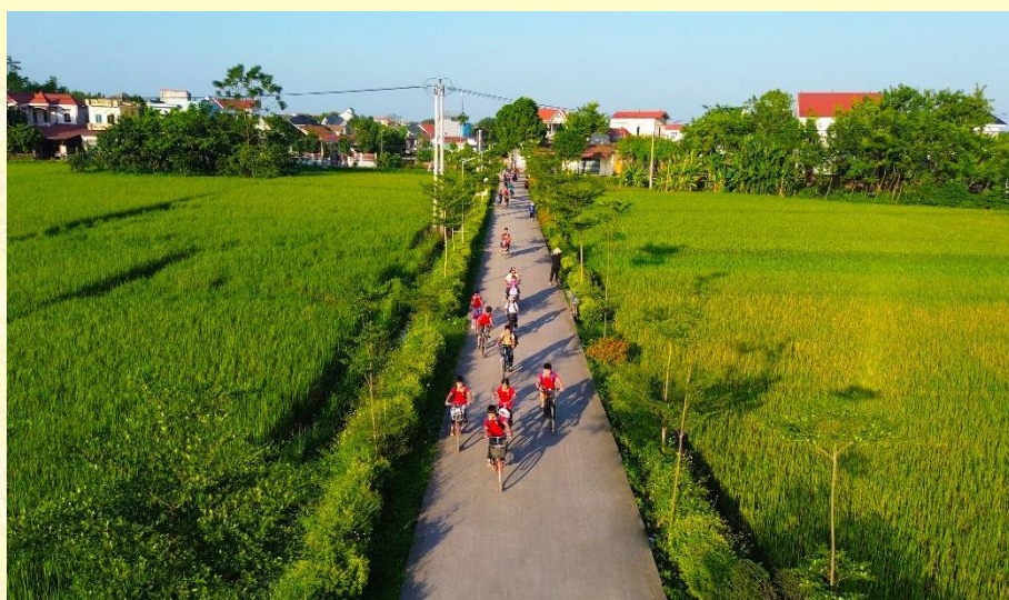
100% đường giao thông liên xã của huyện Phú Bình đã được bê tông hóa, nhựa hóa (ảnh tuyến đường liên xóm xã Thanh Ninh).
