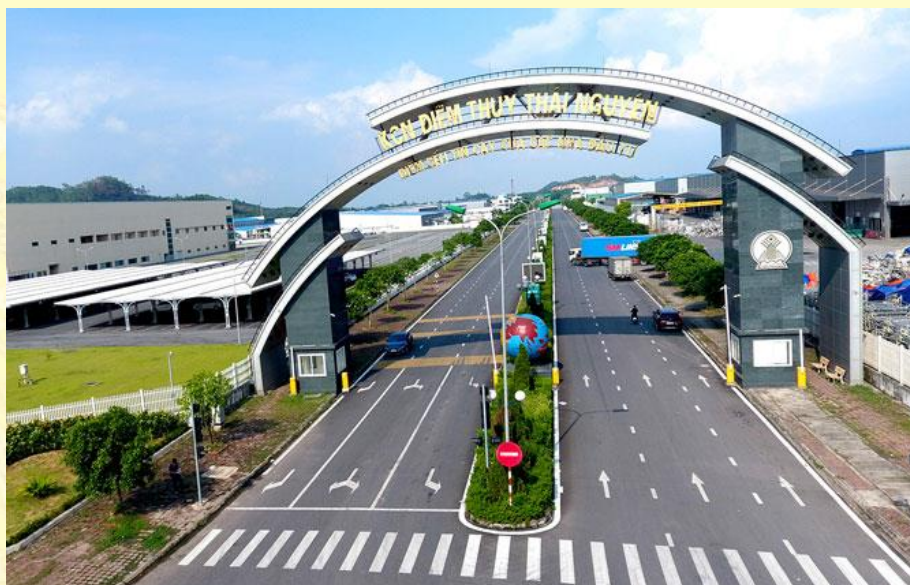
Khu công nghiệp Diêm Thụy, xã Diêm Thụy, huyện Phú Bình (năm 2025)
