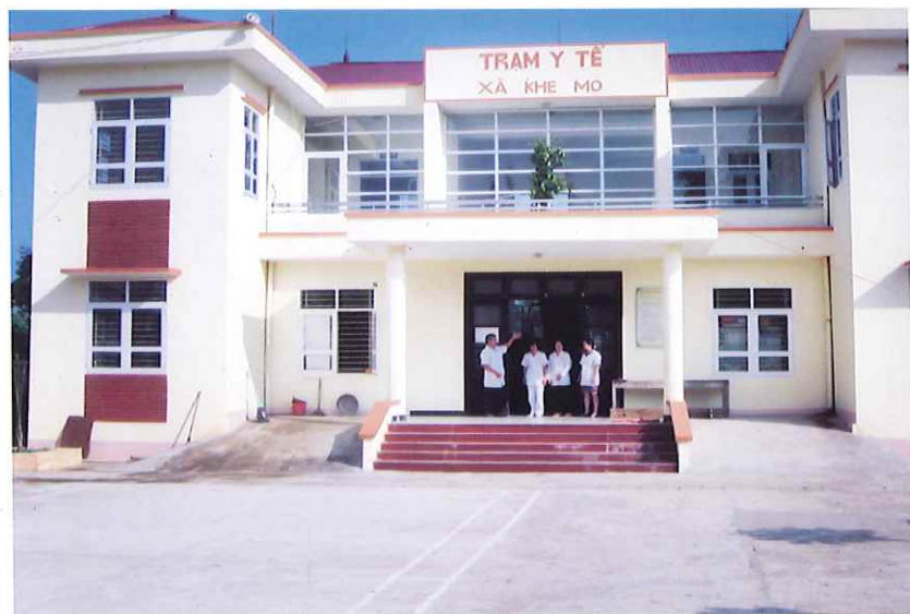
Trạm Y tế xã Khe Mo, đạt chuẩn Y tế năm 2013
