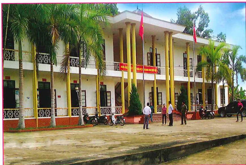
Trụ sở Đảng ủy - HĐND - UBND xã Hợp Tiến (Ảnh chụp năm 2015)
