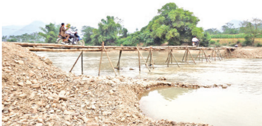
Chiếc cầu tạm nối 2 bờ sông Cầu (2013)
