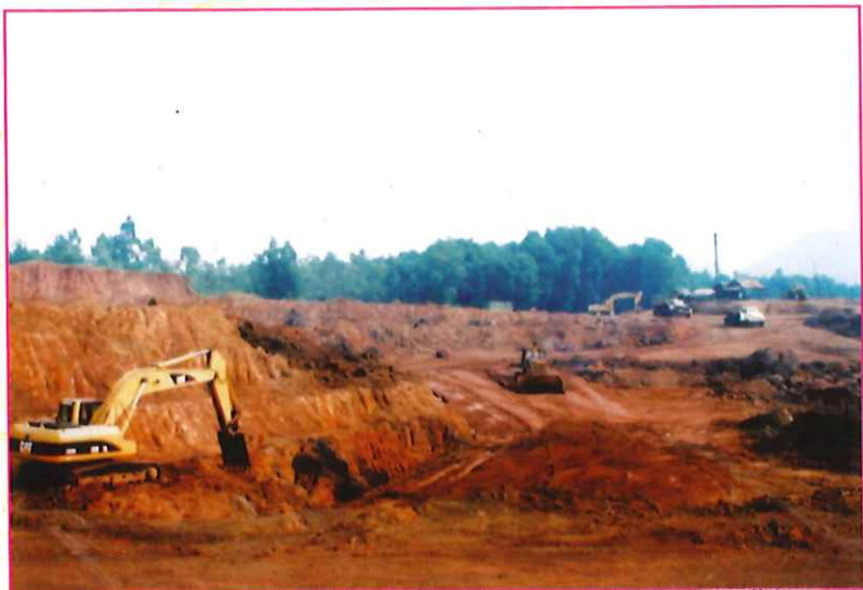
Hoạt động khai thác quặng sắt tại mỏ số 3 Thác Lặc Mỏ sắt Trại Cau
