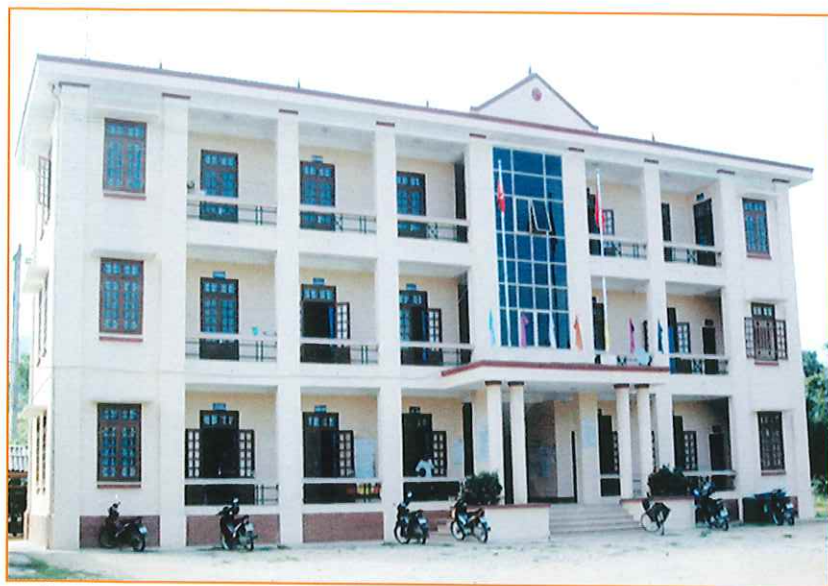
Trụ sở Đảng ủy, Ủy ban nhân dân, Ủy ban Mặt trận Tổ quốc xã Diêm Mặc
