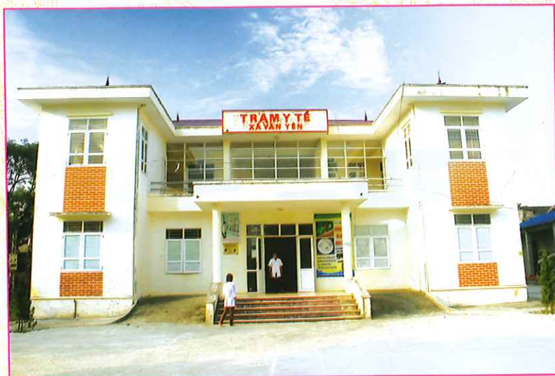
Trạm Y tế xã Văn Yên
