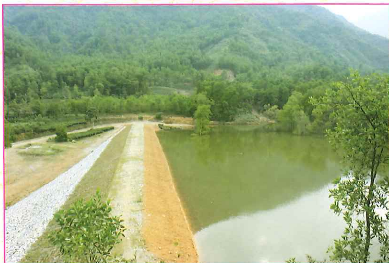
Đập nước hồ Vai Cáy ở xã Văn Yên
