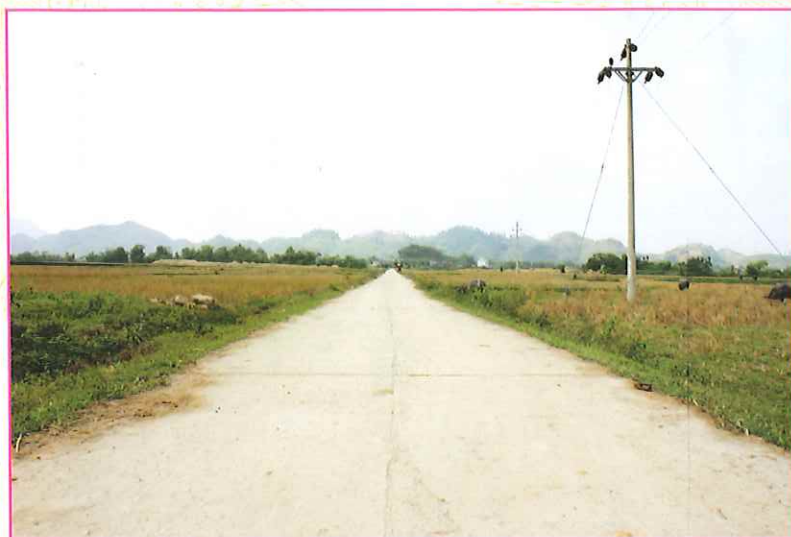
Hệ thống đường liên thôn đã được bê tông hóa ở xã Văn Yên
