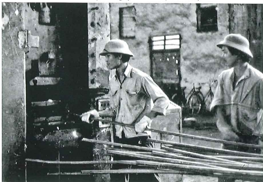
Những năm thời bao cấp để tạo công ăn việc làm Xưởng tận dụng phế liệu để tổ chức sản xuất phụ gồm các mặt hàng dân dụng như: Hàn sơn hoa cửa sổ (ảnh trên), hàn kết cấu thép xây dựng, gia công cắt thép trên máy cắt nguội 200T ... (ảnh dưới)
