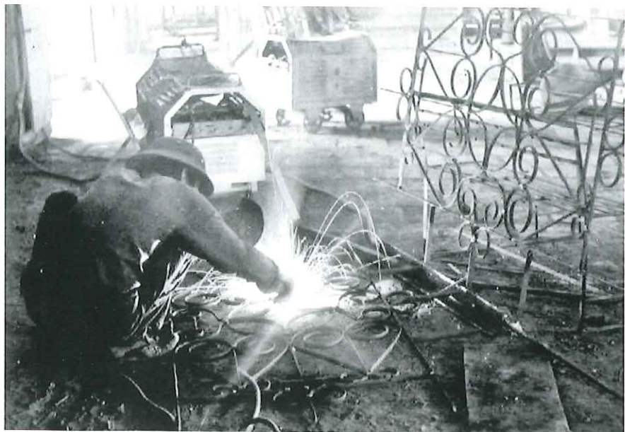
Những năm thời bao cấp để tạo công ăn việc làm Xưởng tận dụng phế liệu để tổ chức sản xuất phụ gồm các mặt hàng dân dụng như: Hàn sơn hoa cửa sổ (ảnh trên), hàn kết cấu thép xây dựng, gia công cắt thép trên máy cắt nguội 200T ... (ảnh dưới)
