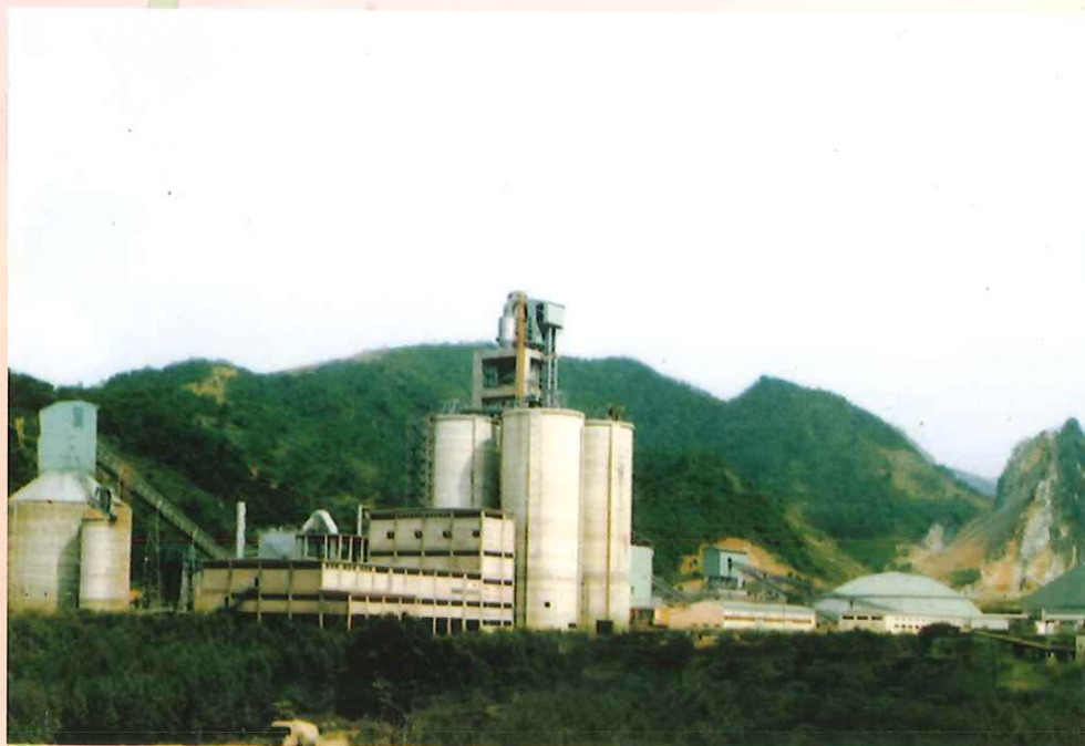
Nhà máy Xi măng Quang Sơn (Ngân hàng NN&PTNT tỉnh Thái Nguyên đồng tài trợ đầu tư xây dựng)
