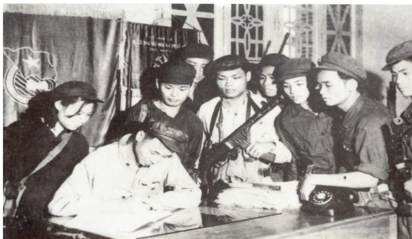
Cô Công nhân Nhà máy Điện Cao Ngạn đăng ký lên đường nhập ngũ năm 1967
