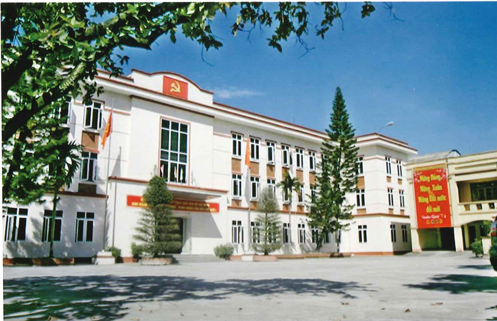
Trụ sở làm việc của Đảng ủy Khối Doanh nghiệp tỉnh Thái Nguyên (Tổ 17, Phường Trung Vương, T.P Thái Nguyên, tỉnh Thái Nguyên)
