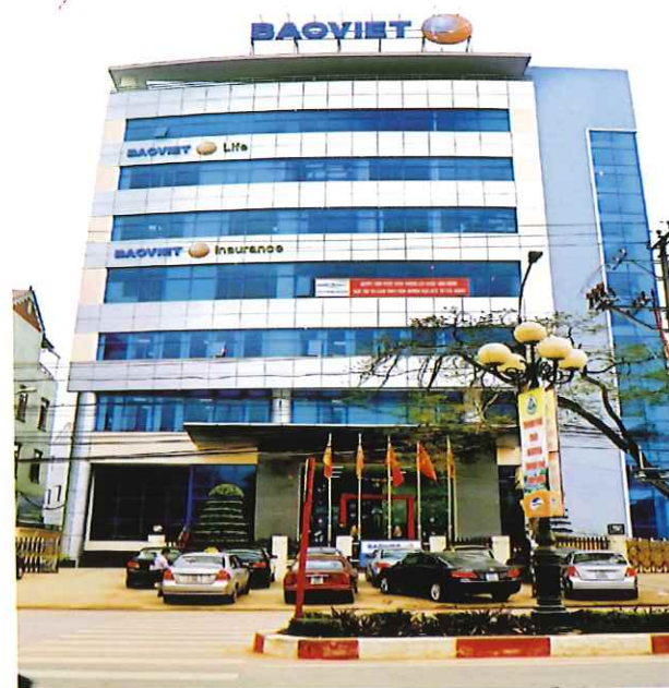
Trụ sở Công ty đặt tại số 51, đường Hoàng Văn Thụ, phường Phan Đình Phùng, thành phố Thái Nguyên
