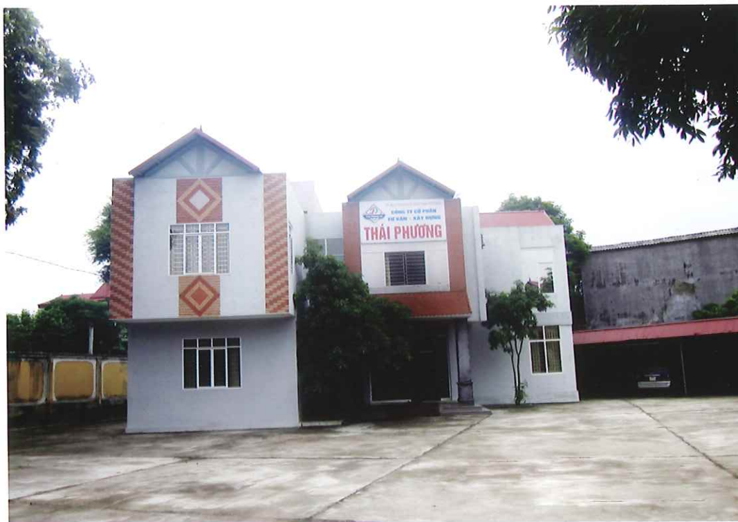
Trụ sở Công ty đặt tại Tổ 1, phường Chùa Hang, Thành phố Thái Nguyên, tỉnh Thái Nguyên
