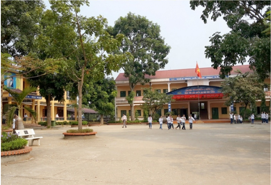
Trường Trung học cơ sở Nam Tiến, huyện Phổ Yên Trường chuẩn quốc gia giai đoạn 1 năm 2012
