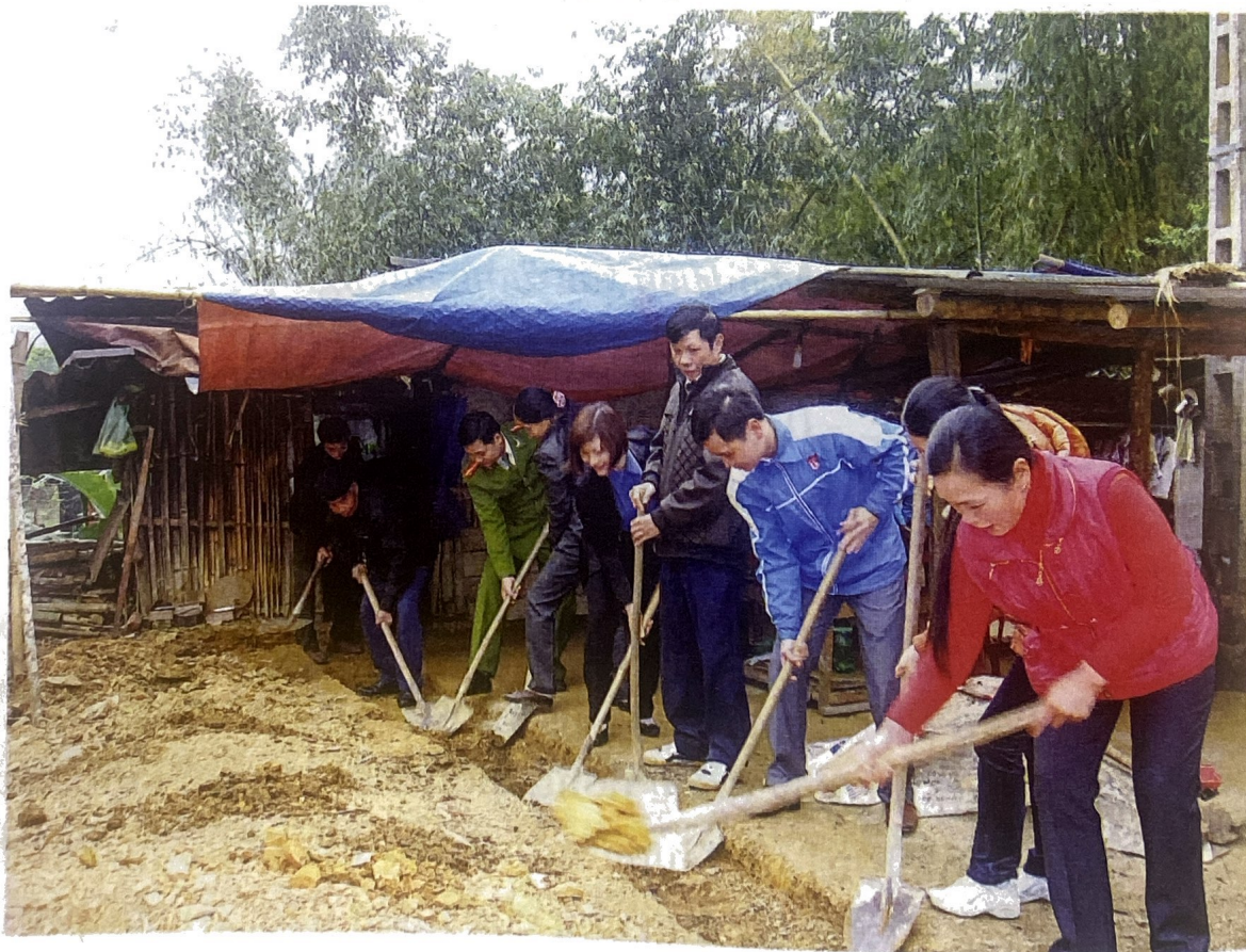
Khởi công xây dựng nhà tình thương
