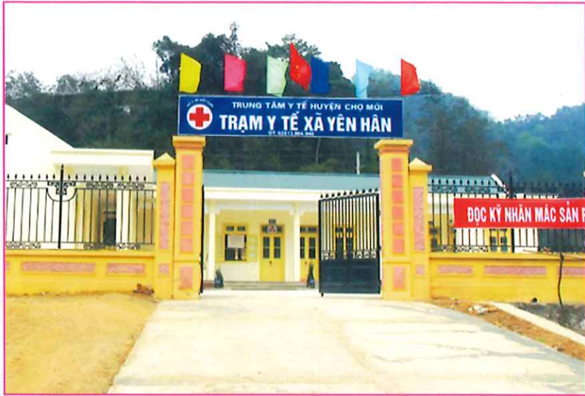
Trạm y tế xã Yên Hân
