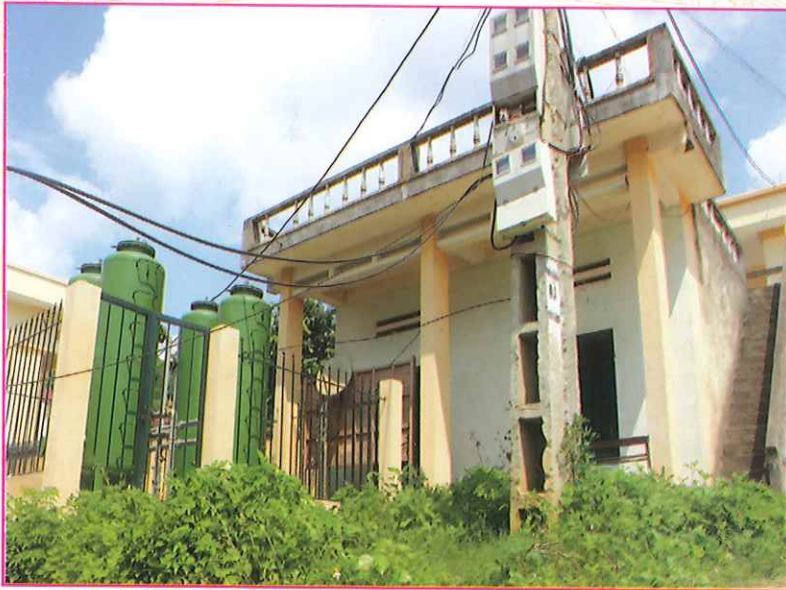
Trạm cung cấp nước sạch xã Nam Cường
