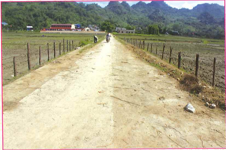
Hệ thống đường giao thông nông thôn xã Nam Cường đã được bê tông hóa
