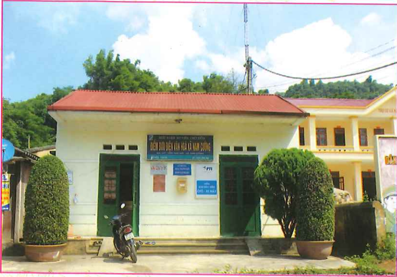
Bưu điện xã Nam Cường
