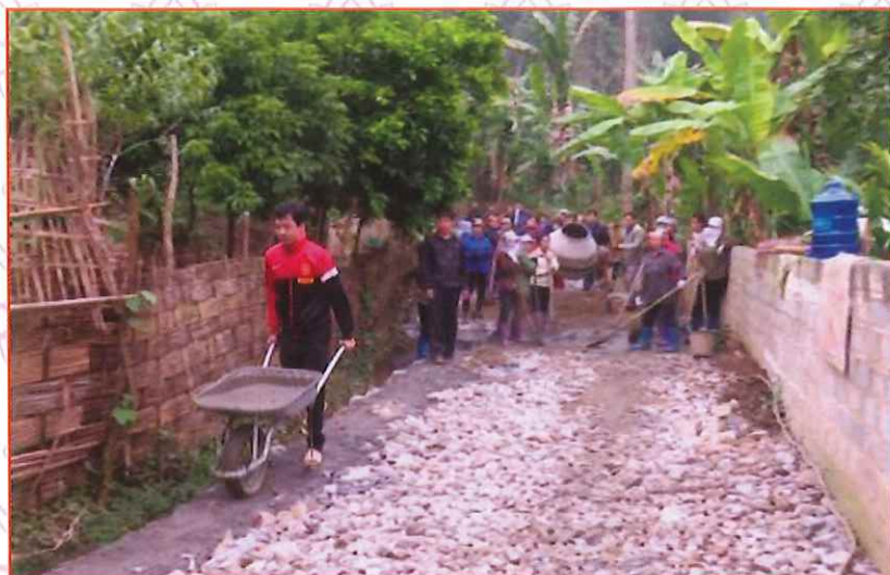
Sở GD&ĐT Bắc Kạn hỗ trợ người dân Bản Chang, xã Hòa Mục, huyện Chợ Mới đổ bê tông đường giao thông nội thôn
