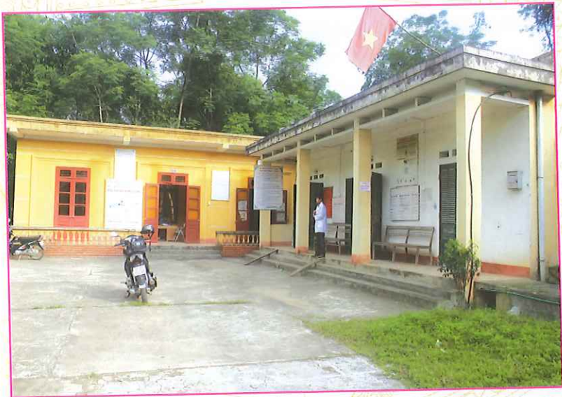
Trạm Y tế xã Đại Sào
