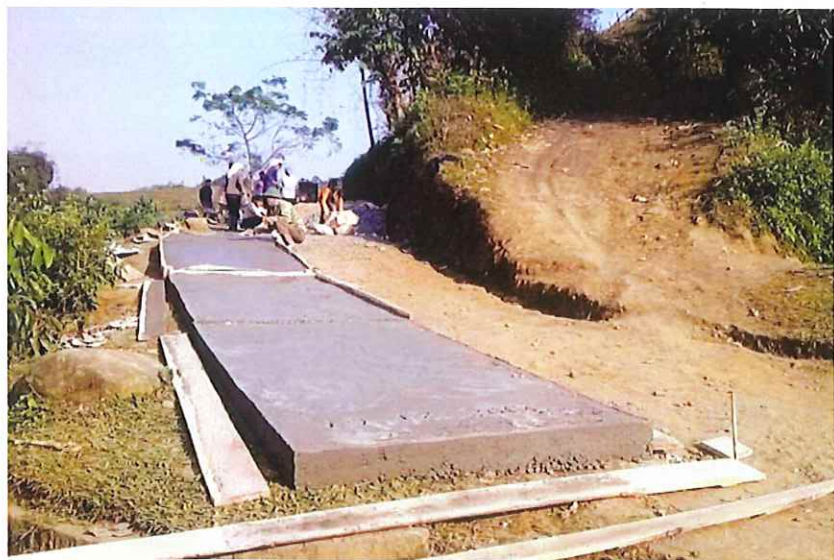
Xây dựng đường nông thôn mới thôn Nà Chảo năm 2014
