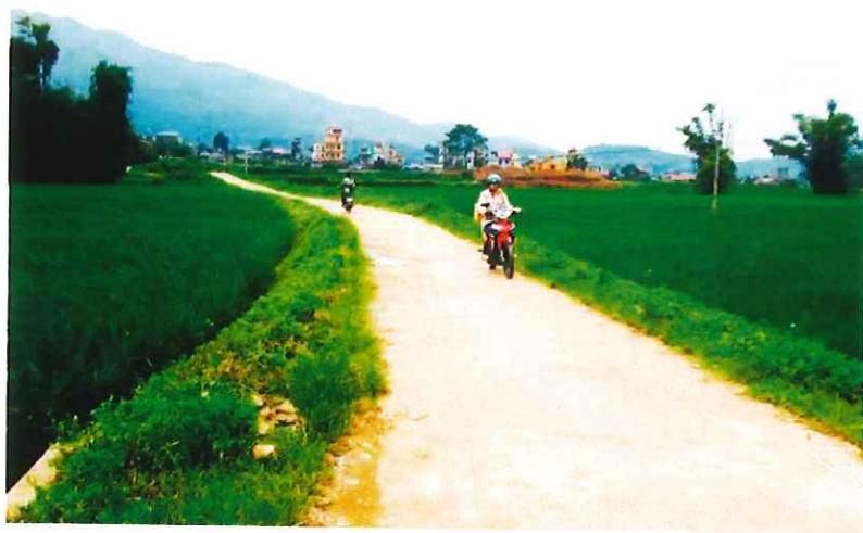
Đường giao thông bê tông hóa theo chương trình xây dựng nông thôn mới
