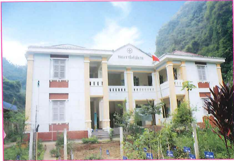
Trạm Y tế xã Bản Thi
